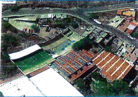
Vista real de la barda de lindero
